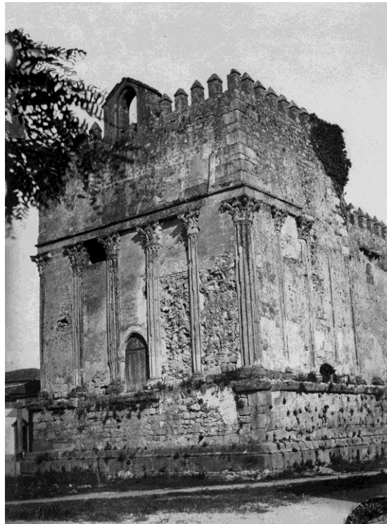
Figura 1 - Templo Romano de Évora, antes da intervenção de Giuseppe L. Cinatti, quando terá servido de “casa-forte” e de açougue.
