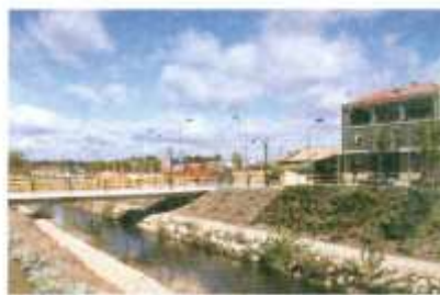
Nuevo puente sobre el Esgueva. Acceso a Serranía de Ronda
