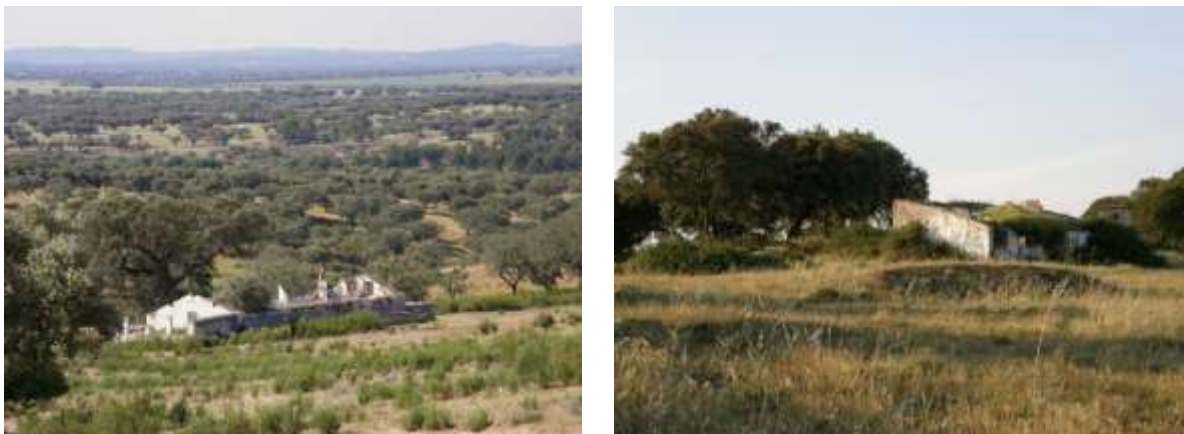
Fig. 6 – Dois montes abandonados e em ruínas: à esquerda, um monte na Herdade de Tera e, à direita, o Monte do Madeira (Foto: J. M. de Mascarenhas, 2009).
