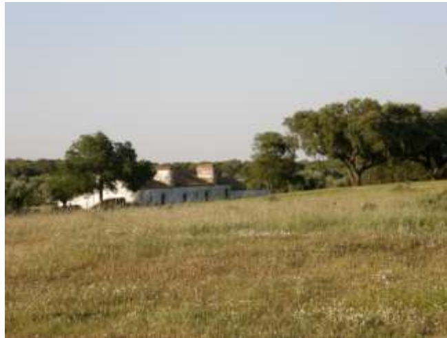
Fig. 3 – Outro exemplo, agora de um monte localizado nos arredores de Évora, um bom exemplo de uma estrutura mais simples e isolada do habitat principal, mas que já perdeu a sua primitiva funcionalidade (casa de trabalhadores rurais). O risco de degradação deste tipo de estruturas é grande (Foto: J. M. de Mascarenhas, 2009).
