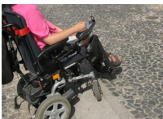
Rampas de inclinação difícil (Museu do Artesanato).
